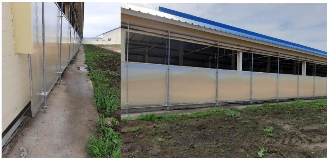
***Рисунок 17 – Вентиляционные шторы***
